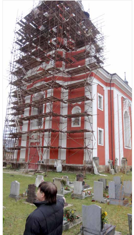
Bild 1: Außenansicht der Kirche in Arnsdorf mit Marcel Hrubý
